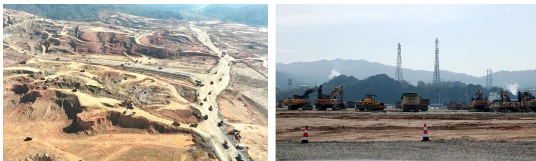
图 4 中国石化岳阳地区乙烯炼化一体化项目场地平整工地
